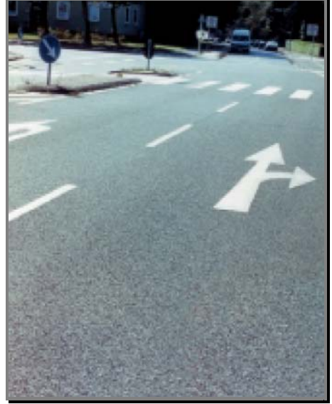
Wilhelmshafen’da 20 yıllık kullanım süresinden sonra taş mastik asfalt 0/8
