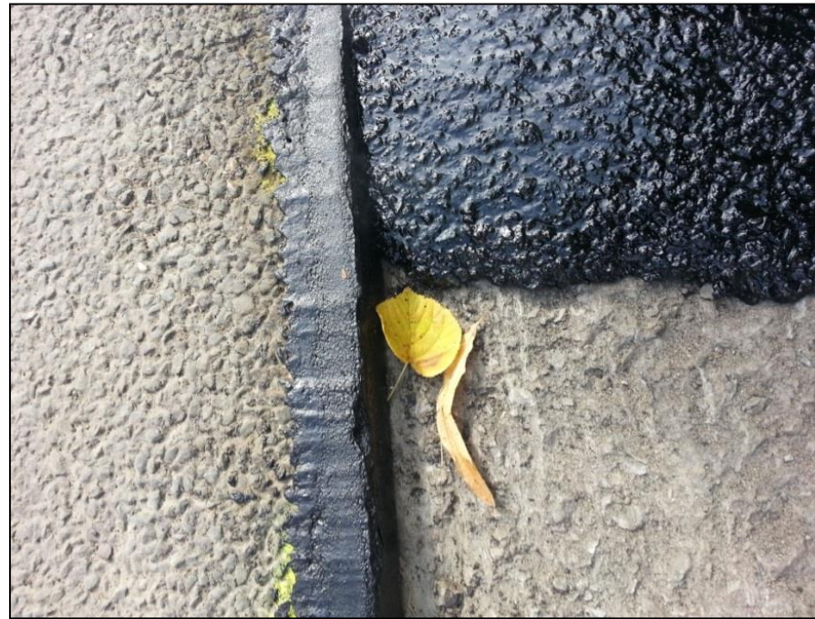
Bitumenfugenband an Gussasphalt.
