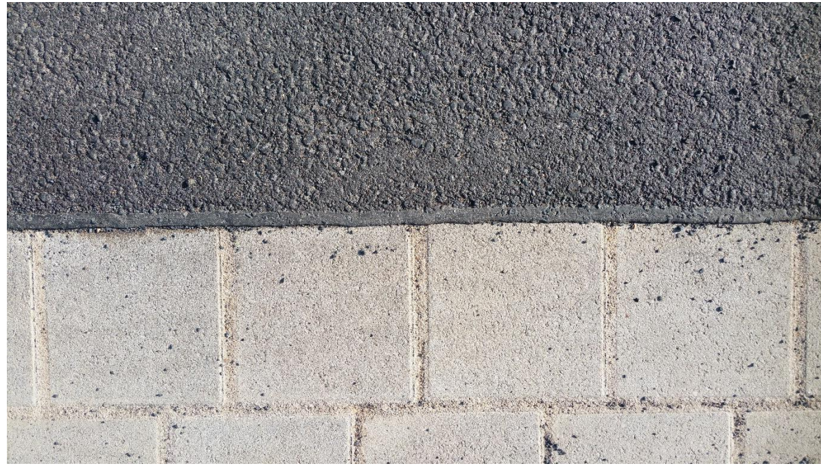
Bitumenfugenband an einer Betonsteinrinne.
