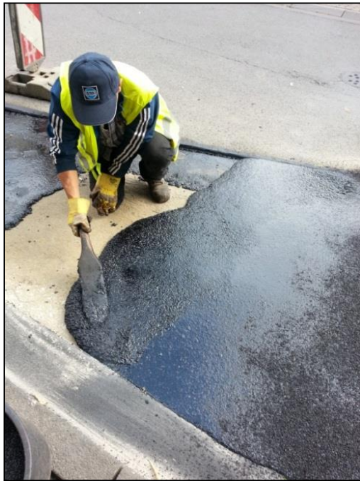
Bitumenfugenband an Gussasphalt.
