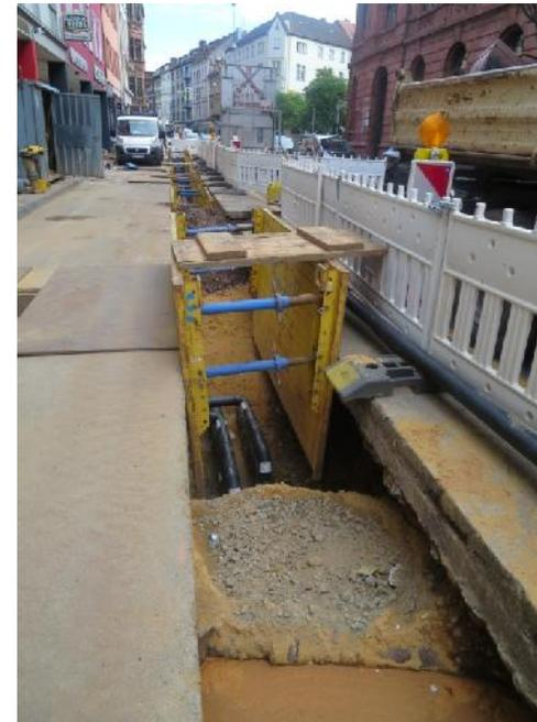
Um spätere Setzungen auszuschließen, muss der Grabenverbau großflächig bündig an der Grabenwand anliegen. Hinter der Baugrubenverkleidung entstandene Hohlräume sind unverzüglich kraftschlüssig zu verfüllen.
