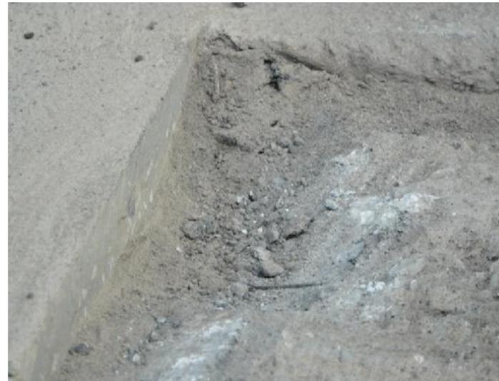
Zwischen den einzelnen Asphaltsschichten ist ein ausreichender Schichtenverbund durch Anstrichen zu sichern
