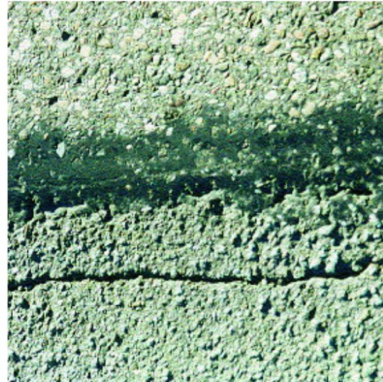
Alle Asphalt-schichten sind mit einem durchgehenden Schnitt zu schneiden, ein Versatz der Schnitte in den Schichtgrenzen ist falsch und führt in der Regel zu **Projektionsrissen**
