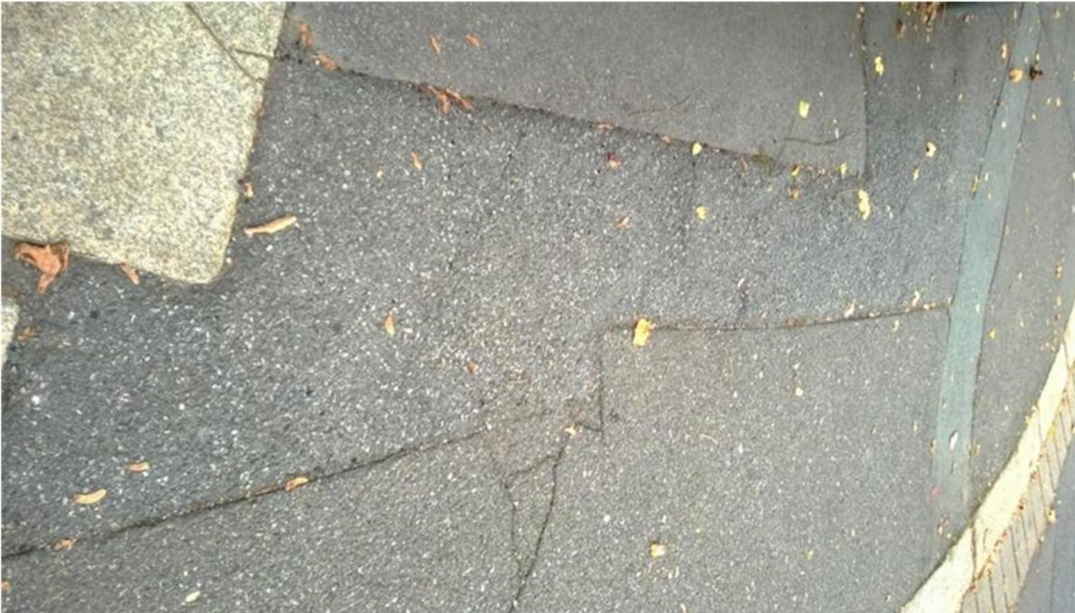
Das Herausfräsen der Asphalttragschicht um die Dicke der einzubauenden Asphaltdeckschicht darf seitlich (und zu Beginn bzw. am Ende) nicht über das Maß des bestehenden Anschlusses hinausgehen sonst besteht die Gefahr von Projektionsrissen!
