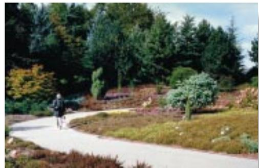
Gußasphalt mit eingedrücktem Kies oder Splitt ist von herkömmlichen Kieswegen kaum zu unterscheiden – aber pflegeleicht und immer befahr- bzw. begehbar
