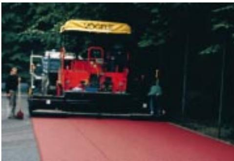
*Roter Asphalt wird mit normalen – aber von schwarzem Asphalt gesäubertem – Arbeitsgerät eingebaut*
