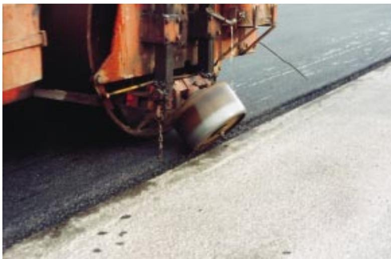
*Kantenformung erfolgt ggf. durch schräg gestellte Begrenzungsbleche am Fertiger und/oder – wie hier im Bild – durch anschließendes Formen und Verdichten einer Kantenrolle an der Walze*
