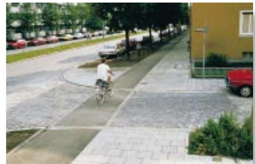
Eine Radfahrerfurt muß nicht immer markiert werden, sie kann auch durch das Durchziehen der Verkehrsflächenbefestigung des Radwegs hervorgehoben werden, wenn diese durch eine Teilaufpflasterung einer einmündenden Nebenstraße geführt wird (Standardlösung bei Tempo-30-Straßen). Radwegbefestigungen aus Asphalt sind für solche „Radwegüberfahrten“ besonders geeignet.
