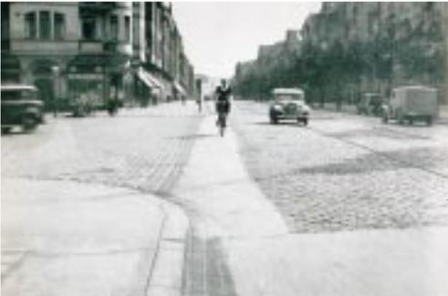
*Pflasterüberzug aus Asphalt – zur besseren Befahrbarkeit und zur Linienführung des Radfahrers im Kreuzungsbereich*
