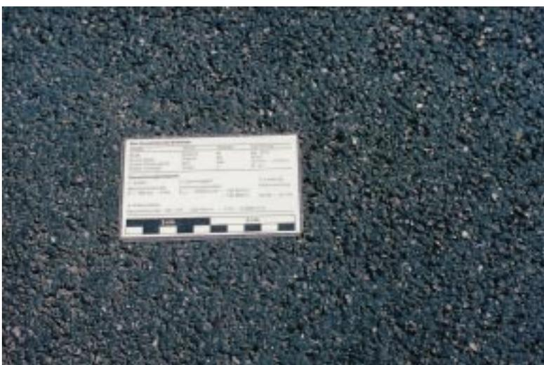
Wenn durch Abrieb oder Witterung die Spitzen der Splittkörner freigelegt werden, sind Farbe und Griffigkeit wieder hergestellt. Den gleichen Effekt – nur in extremem Zeitraffer – bringt das Abstreuen mit Splitt
