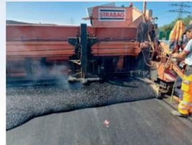
Bild 1: Beim Einbau von MA 8 S mit INDULIN AD2 auf der K 20 (BAB A 7) südlich des Elbtunnels entstehen auch bei annähernd 230 °C Einbautemperatur weniger Dämpfe und Aerosole
