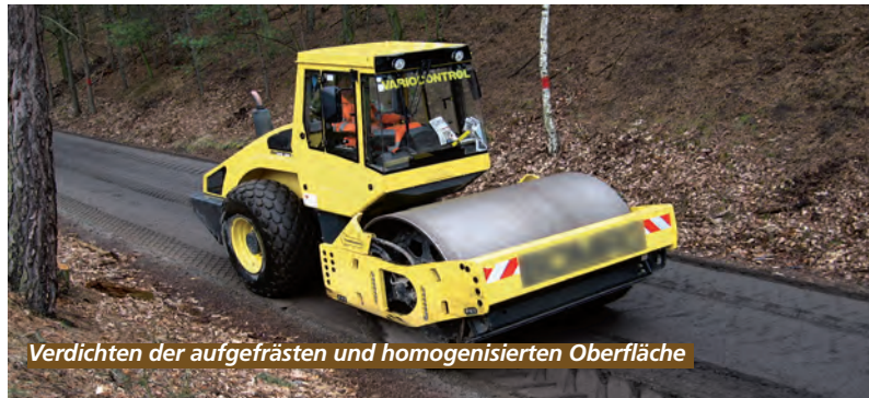
Nach Auffräsen und Homogenisieren der vorhandenen Radwegbefestigung
