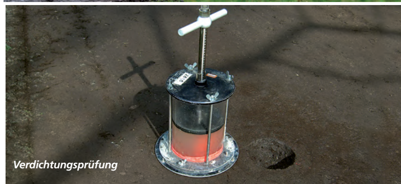
Verdichten der Kaltrecycling-Oberfläche
