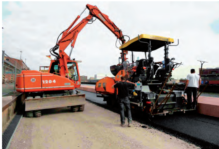
Beschickung des Straßenfertigers mittels Bagger direkt vom LKW
