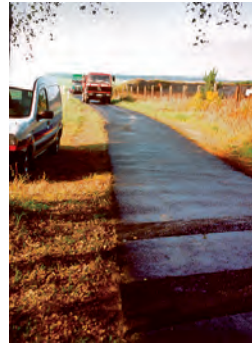
Vorflickung eines schadhaften Radweges
