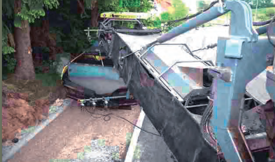
Beschickung des Straßenfertigers mittels eines „Beschickers“ (Übergabefertiger)
