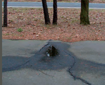
Einwuchs von Baumwurzeln unter der Asphalttragschicht
