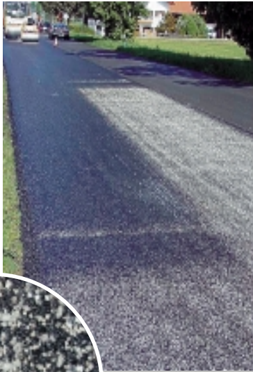
Walzasphalt – Oberfläche vor und nach dem Abstumpfen (Detail)
