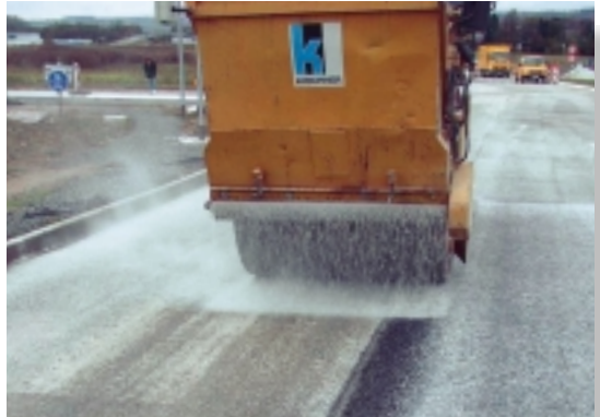
Gleichmäßiges Aufbringen des Abstreumaterials
