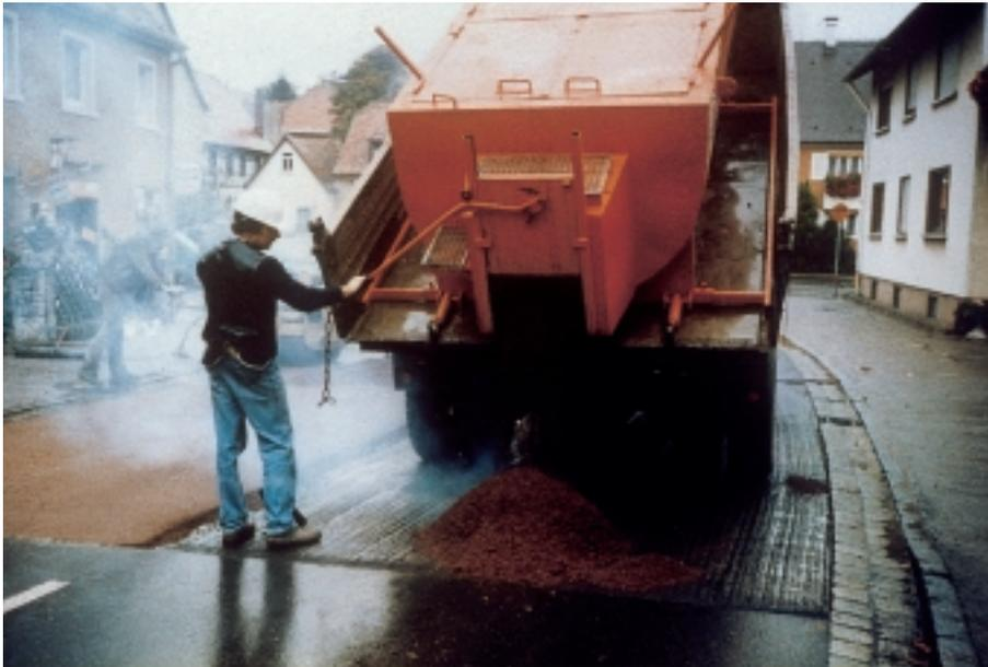
**Anlieferung eines rot eingefärbten SMA im Thermobehälter**
