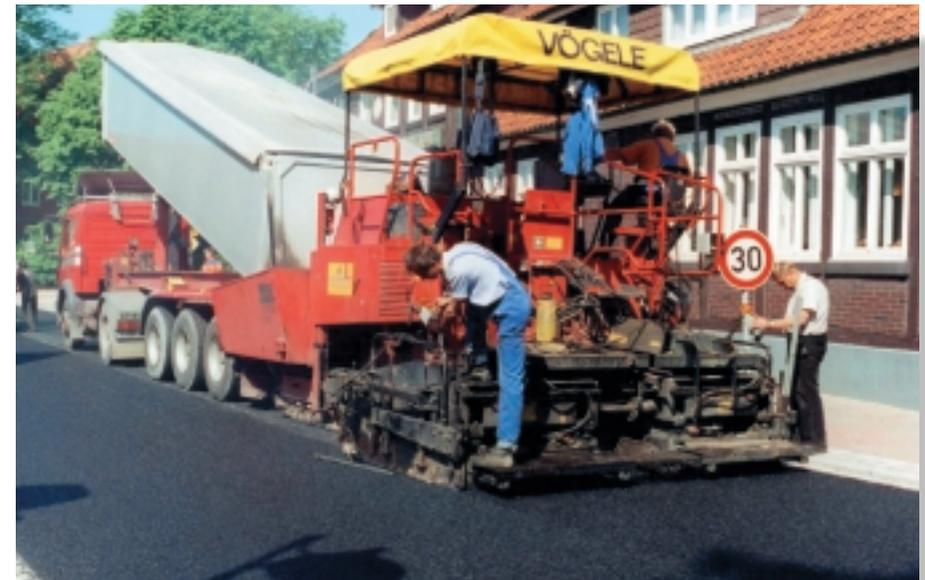
*Einbau einer dünnen SMA-Deckschicht im Bereich einer Ortsdurchfahrt.*
