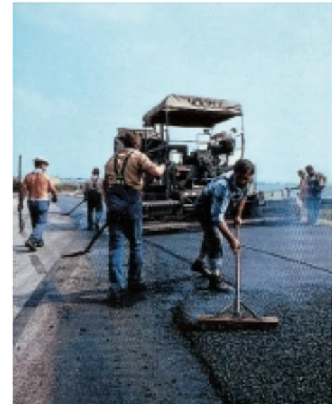
**SMA-Einbau von Hand in Zwickeln und Randbereichen immer gleichzeitig mit dem Fertigerinbau.**
