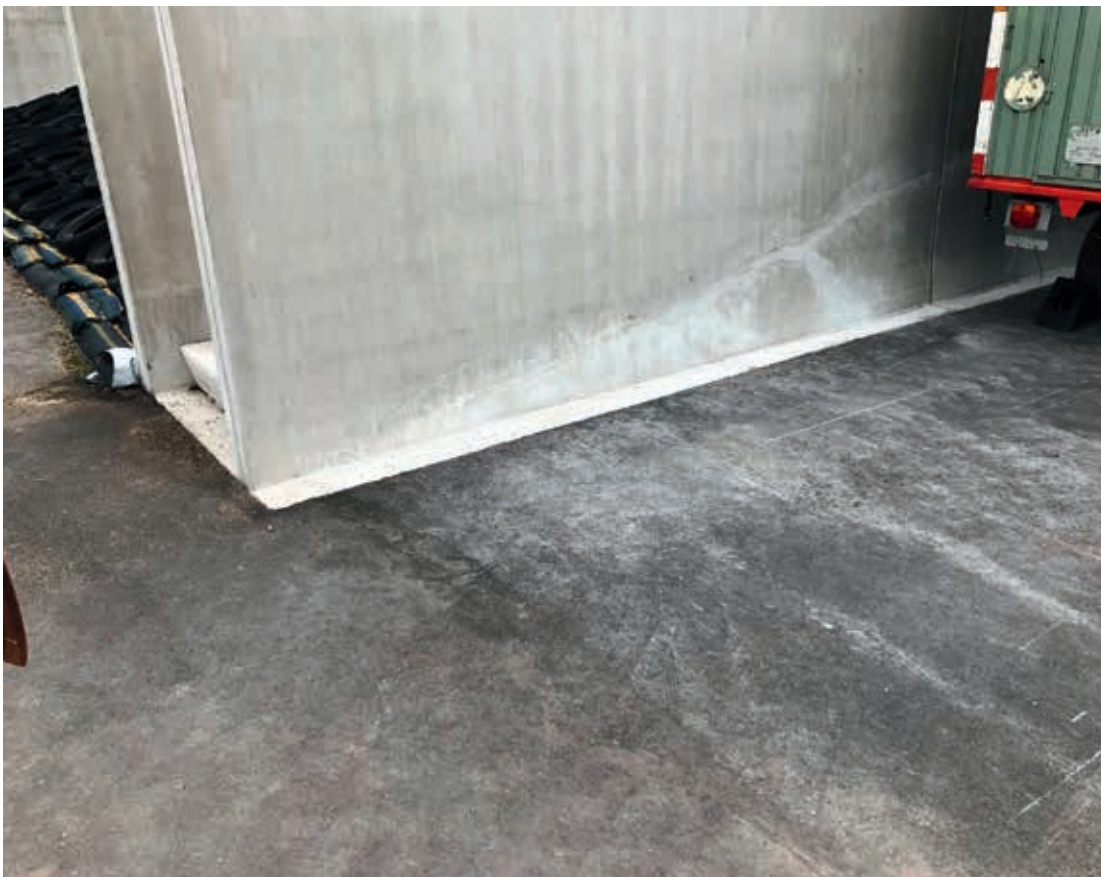
Abbildung 2: U-Wand in die Asphalt-dichtschicht eingebunden (Quelle: Louis/Feldhaus)
