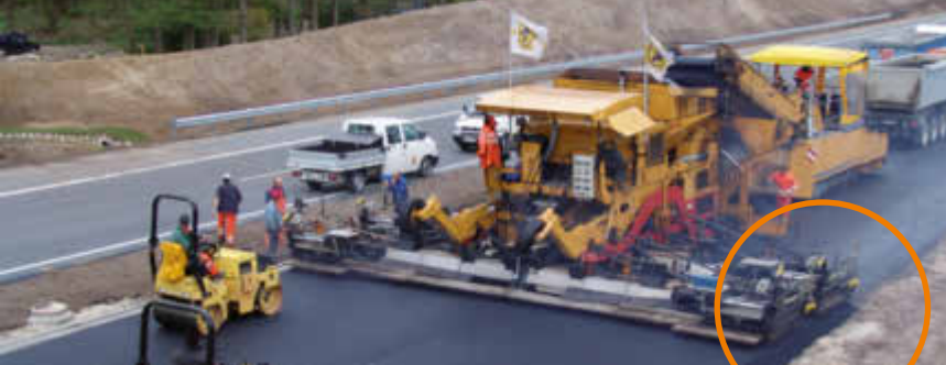
Spezialfertiger mit zwei Einbaubohlen
