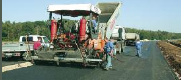
Das Herstellen gleichmäßig dicker Asphalt-schichten setzt eine ausreichend standfeste und ebene Unterlage voraus.
