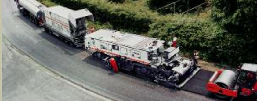
*Kaltrecycler bei der Herstellung einer bitumen-dominanten KRC-Schicht*
