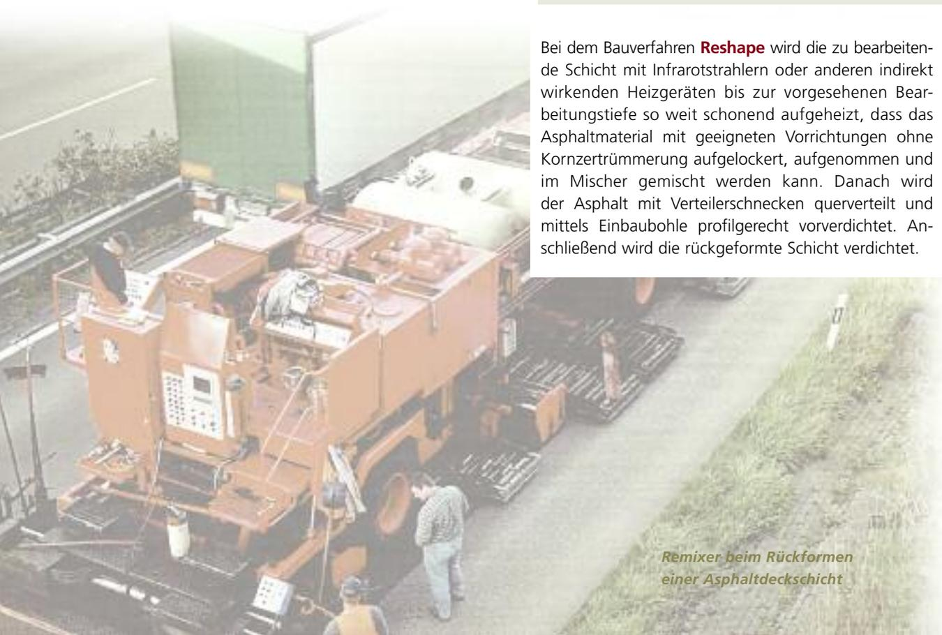
*Remixer beim Rückformen einer Asphaltdeckenschicht*
