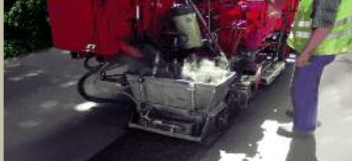
*Nahtremixer bei der Sanierung einer schadhaften Mittelnaht (60 cm)*
