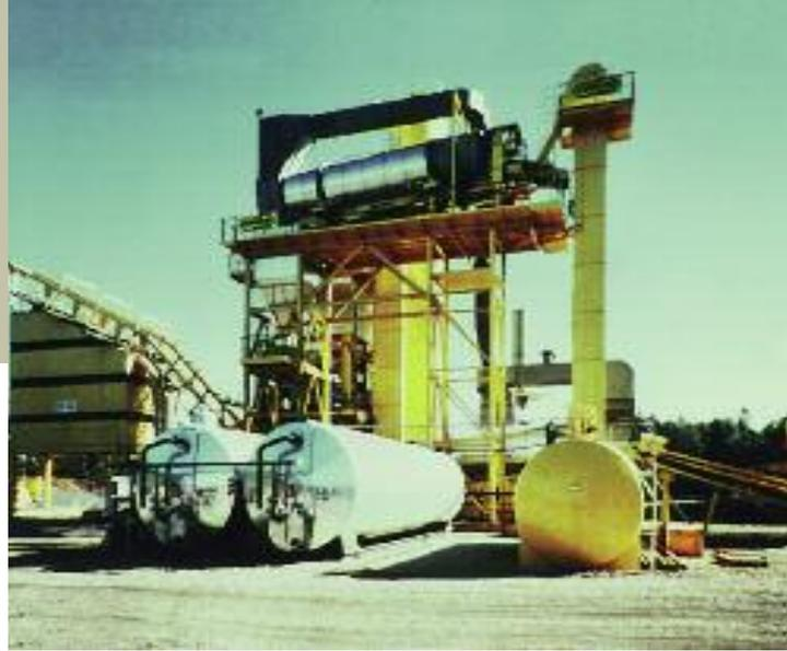
*Paralleltrommel zur schonenden Trocknung und Erwärmung des Asphaltgranulates – hoch gesetzt, damit das erwärmte (und klebende) Asphaltgranulat keine weiteren Fördergeräte verkleben oder zusetzen kann.*
