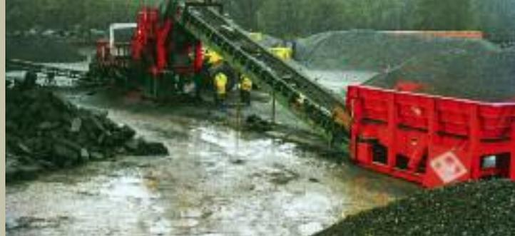
*Zerkleinerung der Asphaltplatten im Brecher*
