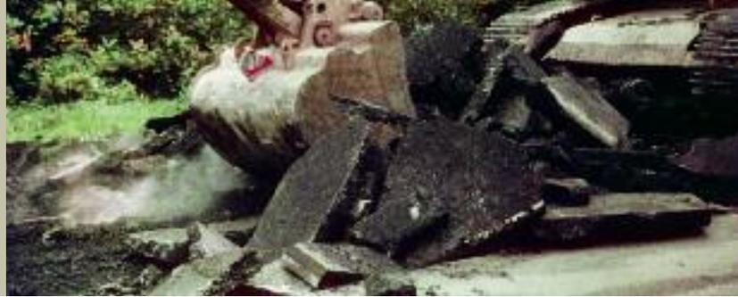
*Aufnehmen eines Schichtenpaketes mit dem Tieflöffel*
